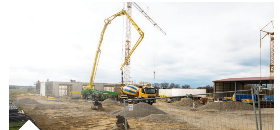
Ein Blick auf die Baustelle des Biomassehofs. Schon bald nimmt die Vergärungsanlage ihren Betrieb auf.
